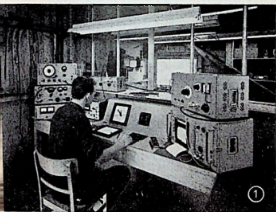
Afb. 1. Meetruimte met controle-panelen voor de afstandsbediening van de antenne.
